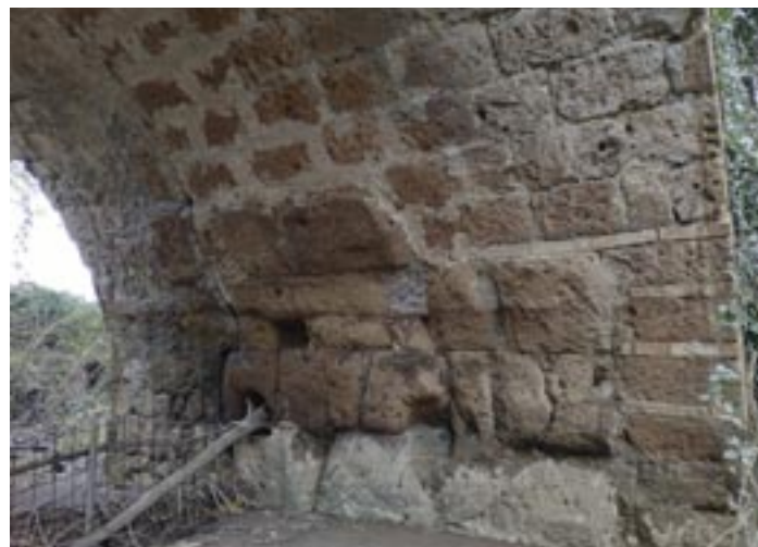
Fig.3- Ponte Ritorto: particolare dei filari di tufo nella spalla sud.
