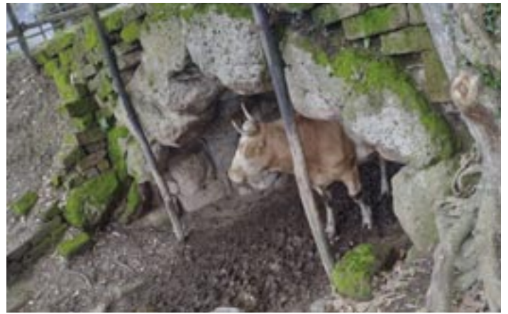
Fig.13 - Sottopassaggio detto la "Voltarella".
