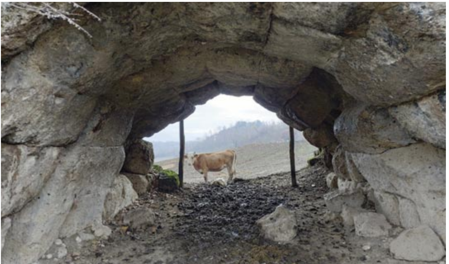
Fig.14 - Parte dell'intradosso della "Voltarella".
