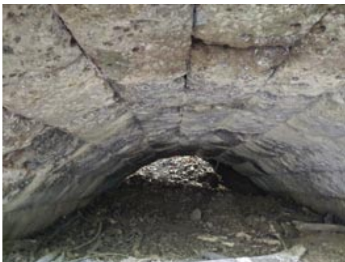
Fig.5- Ponte di Torre Pastore, dettaglio della volta.
